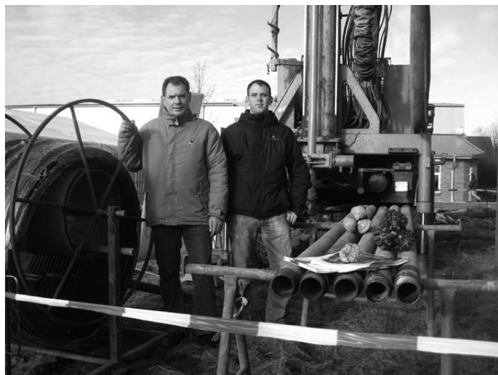
Geschäftsführer Matthias Wiese und Bohrmeister Torben Jöhnk vor dem Bohrfahrzeug und ausgestellten Bohrmaterialien
