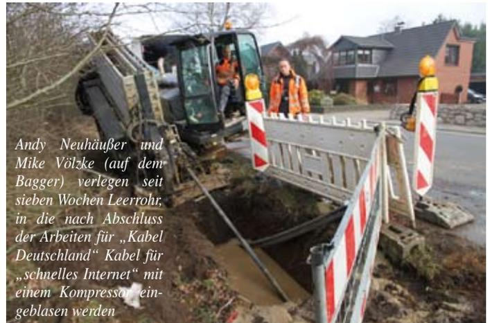
Andy Neuhäuser und Mike Völzke (auf dem Bagger) verlegen seit sieben Wochen Leerrohr, in die nach Abschluss der Arbeiten für „Kabel Deutschland“ Kabel für „schnelles Internet“ mit einem Kompressor eingeblasen werden
