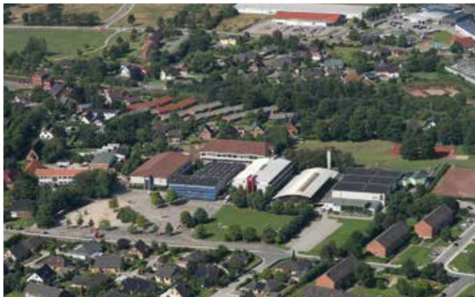
Luftbild Schulzentrum, hier auf dem Schulhof links soll der neue Kindergarten entstehen
