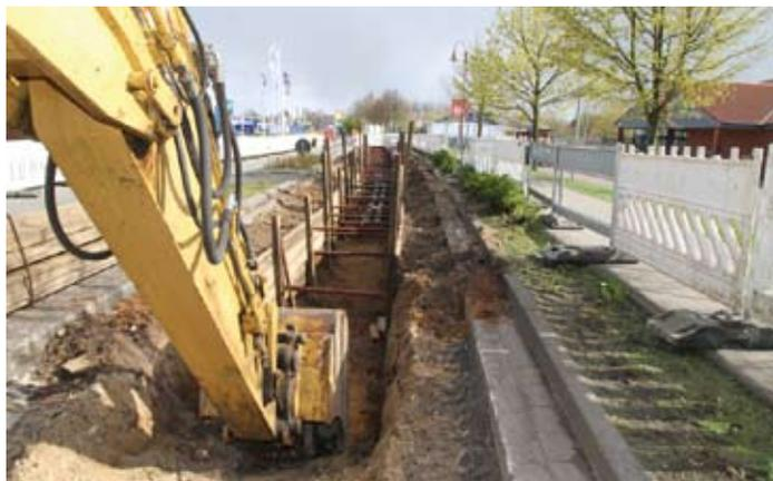
Hier wird die Fernwärmeleitung verlegt, damit das Heizwerk der EON-Hanse von den Stadtwerken versorgt werden kann
