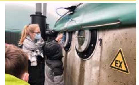
Fynn und Frau Wasse beobachten die Gasentwicklung in einem der Fermenter der Biogasanlage.
