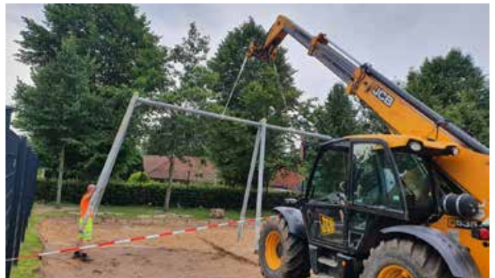
Aufstellen der neuen Schaukel auf dem oberen Schulhof Foto: Torsten Seifert
