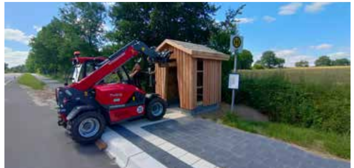
Im Juli wurden die neuen Buswartehäuschen an der L 317 auf ihr Fundament gesetzt.
