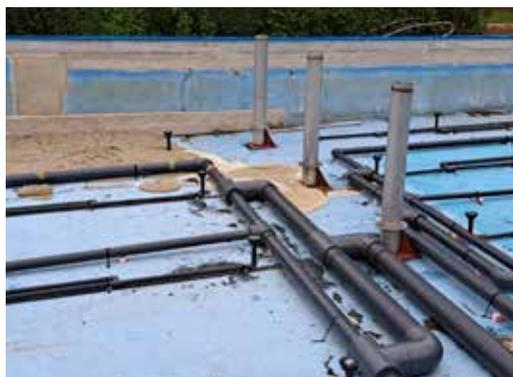
Anpassen des Beckenkörpers an die geplante Verdüsung und den neuen Überlauf.
